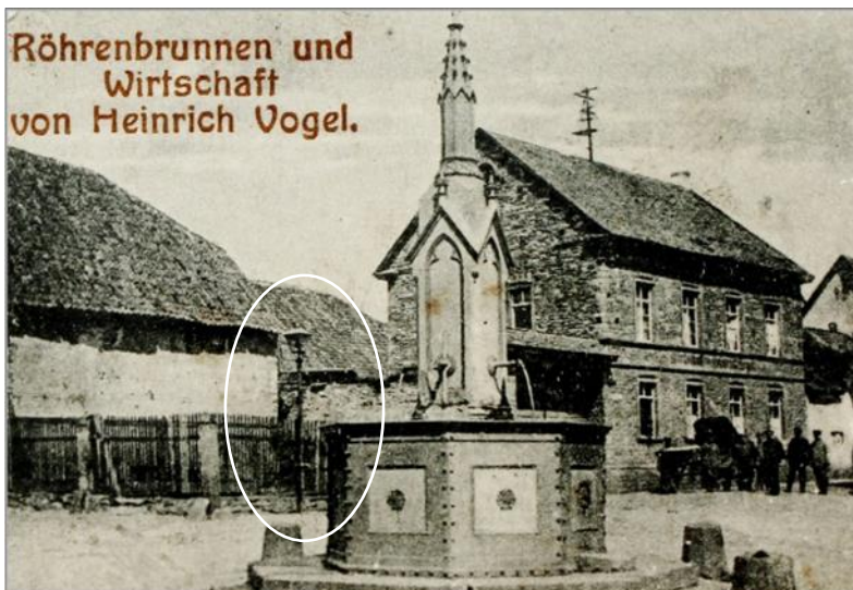
Der Röhrenbrunnen von Frei-Laubersheim 1918
